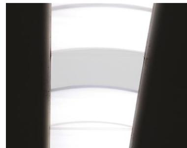
**POLISHIELD “DARK White”** contiene pigmenti che riflettono il calore infrarosso del sole, assorbono la luce ultravioletta, ma risultano traslucidi alla luce visiva. Protegge gli edifici dal surriscaldamento bloccando l'effetto serra creato dall'energia solare diretta, con forte abbattimento della trasmissione luminosa.
